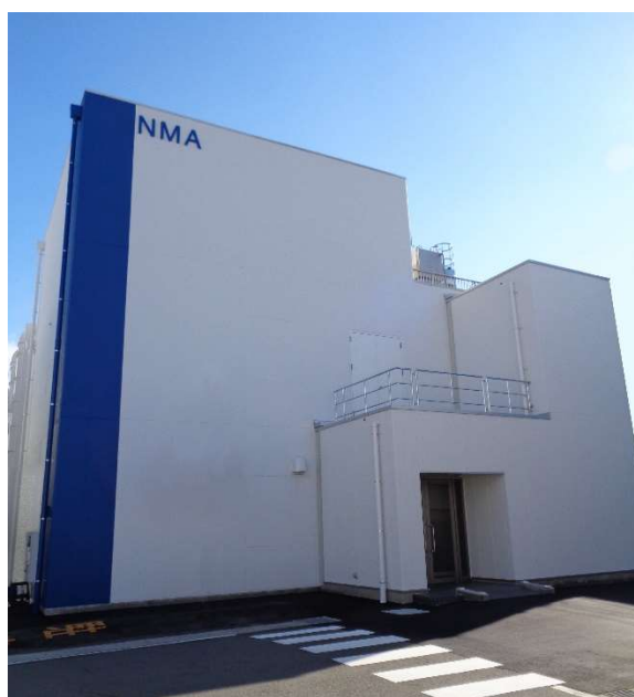
シンクレスト社の鳴門工場
