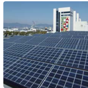
大塚倉庫 今切5号倉庫
