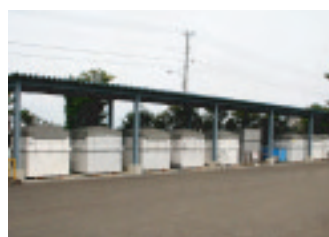
大塚グループ共同焼却炉向けコンテナ置き場の新設
