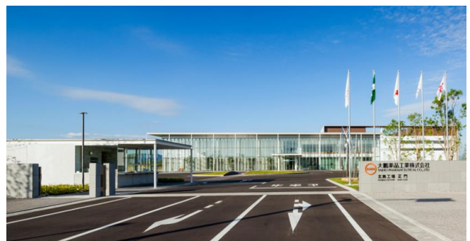
大鵬薬品 北島工場
