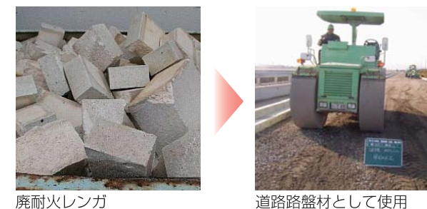
廃耐火レンガ 道路路盤材として使用
