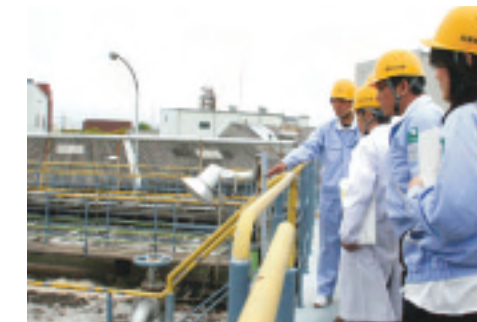
審査状況(排水処理場)
