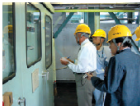
審査状況(焼却炉)
